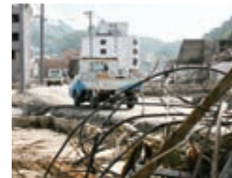
お客さまと。災害時の工事支援。 緊急時の全国災害支援 体制を構築。
